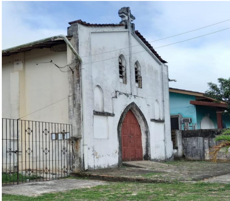
Imagem 9 - Igreja de Mazagão, orla do município – Município de Mazagão
