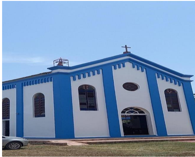
Imagem 7- Igreja Nossa Senhora do Perpétuo Socorro, no bairro da Fazendinha em Macapá
