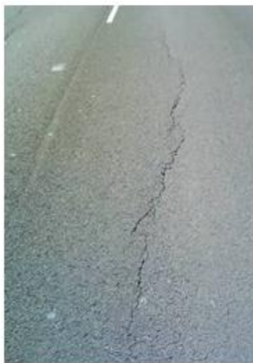
Fig.1 Longitudinal Crack
