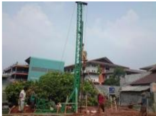
Figure 2.5 Bored Pile Mini Crane
